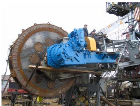
Slika 4. Montaža novog reduktora rotora na bageru SRs 470.17/1,5
