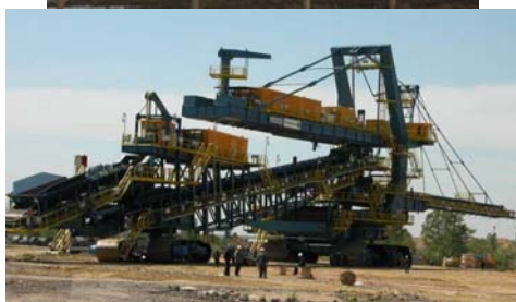
Slika 1. Izgled odlagaca u toku montaže i nakon završetka montaže
